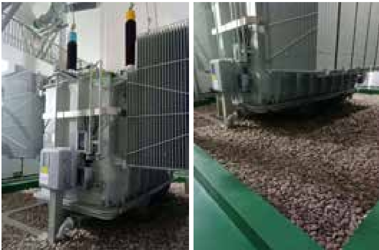
图 9 变电站两台主变事故油坑
