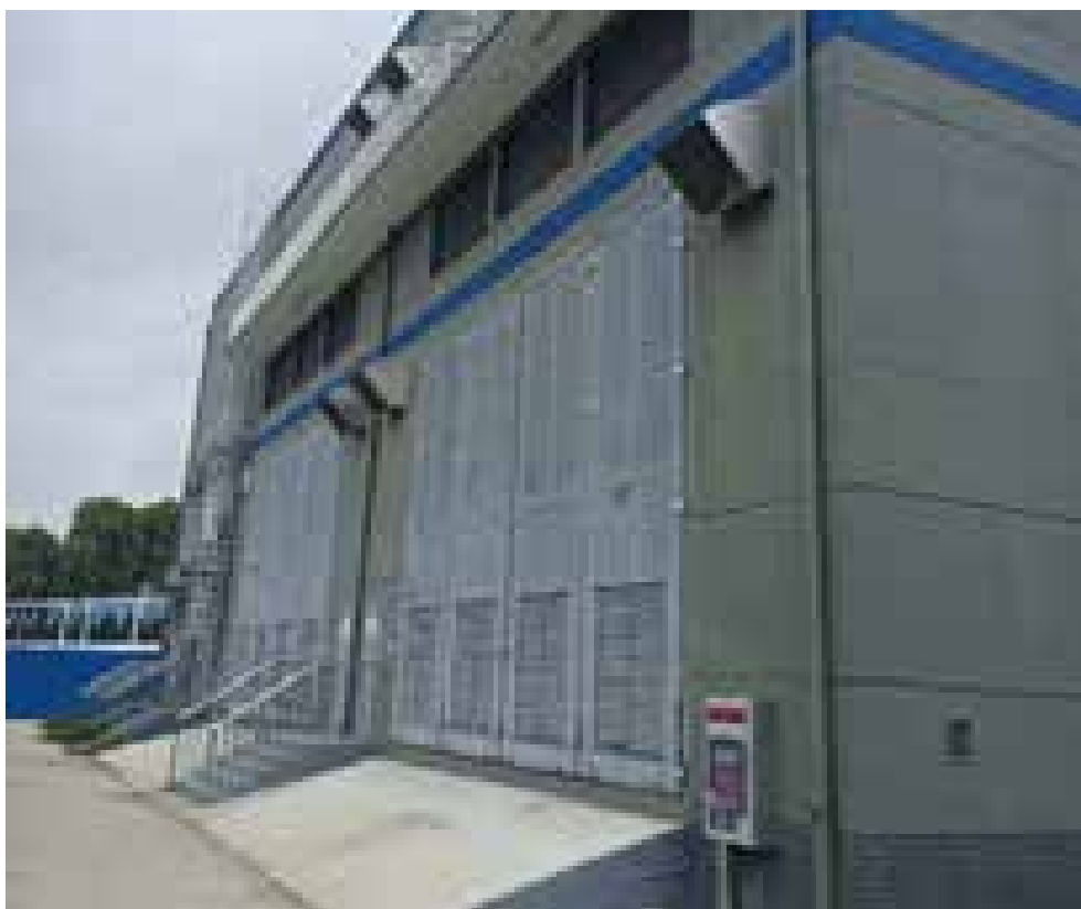
图 10 变电站两台主变室隔声门
